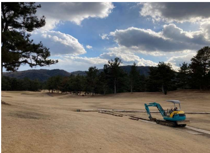
10番ホール 残り160Y付近 掘削状況
