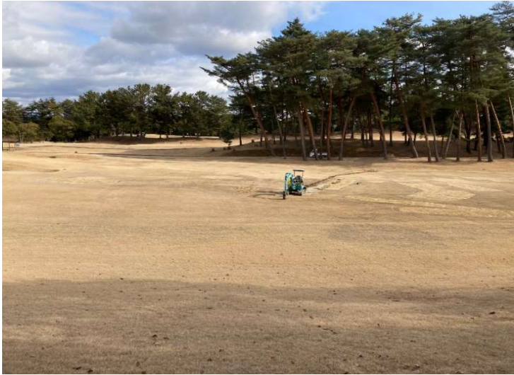
残り80Y付近 掘削状況
