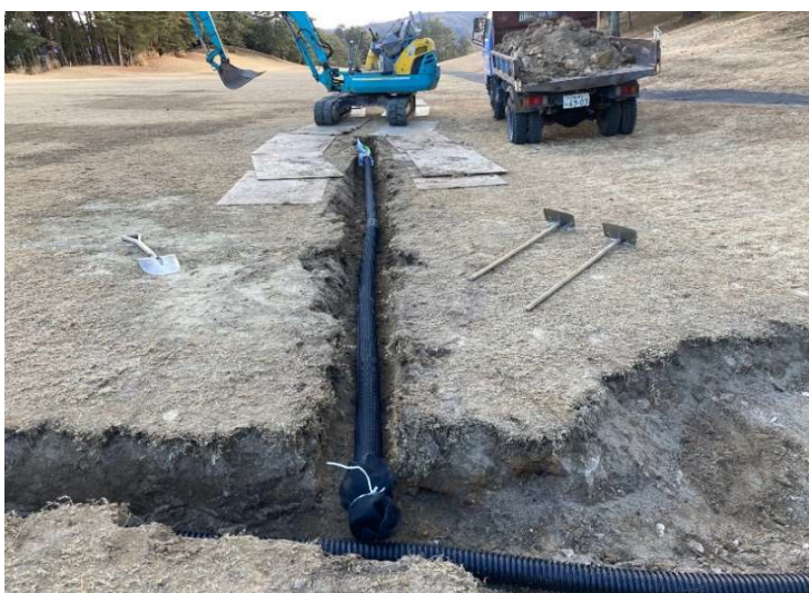
9番ホール 排水管 埋設状況
