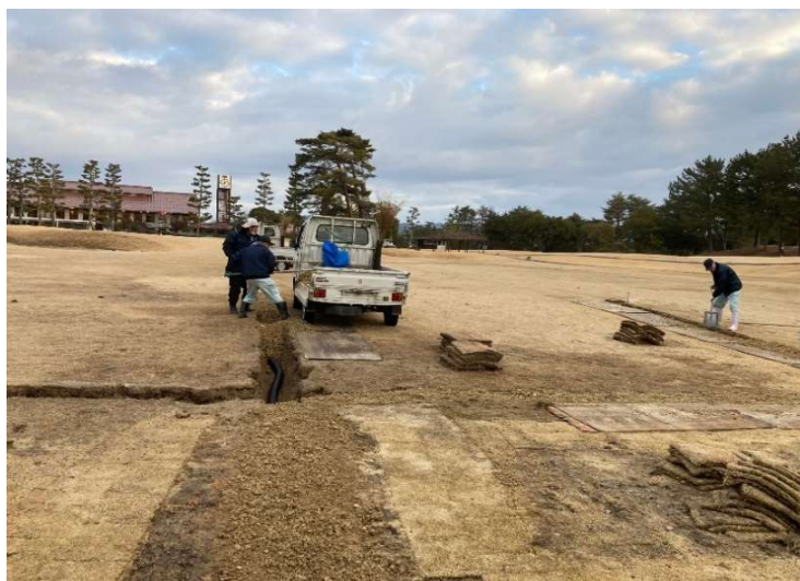
埋め戻し状況
