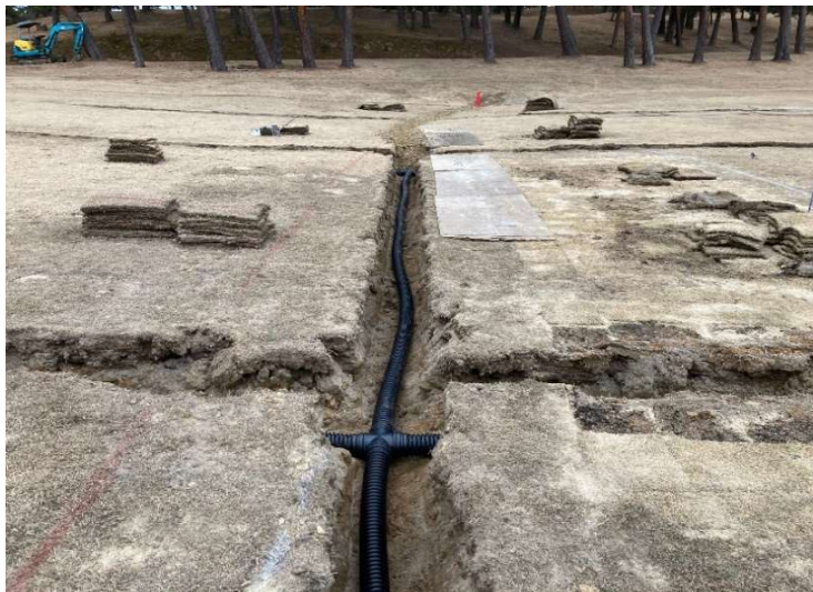
排水管 埋設状況
